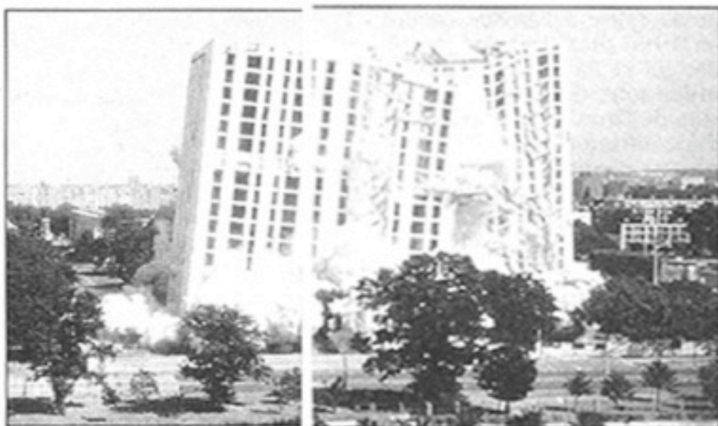
Les images de la série Impressions de Mathieu Pernot ont été prises dans les quartiers périphériques de grandes villes, comme ici à Mantes-la-Jolie. La destruction par explosif des barres d'immeubles visent la mise à mort d'un symbole social. (Photo galerie VU.)
